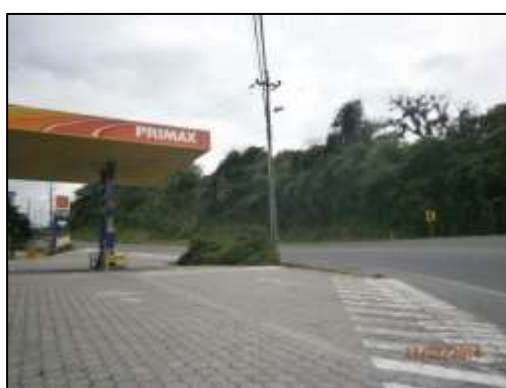
Fotografía N°. 8 Marquesina
